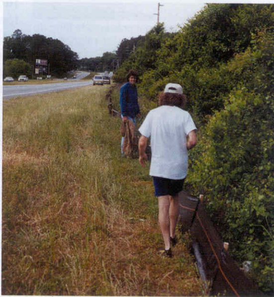
Fig. 2 : Écran protecteur pour éviter l'écrasement des tortues le long de l'autoroute.
